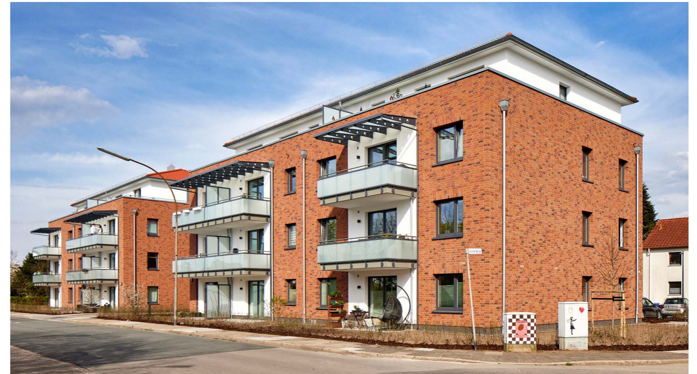
Im Appenstedter Weg in Seevetal-Meckelfeld entstanden zwei Wohngebäude mit insgesamt 22 Wohnungen sowie 37 Kfz-Außenstellplätzen. Die Wohnanlage wurde nach dem Standard KfW-Effizienzhaus-55-EE errichtet.
