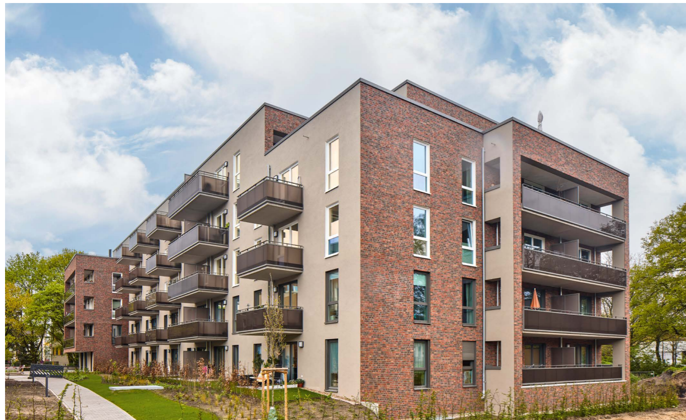
Weidenkehre in Neugraben-Fischbek: Nach rund 22 Monaten Bauzeit wurden im März 2024 45 öffentlich geförderte Neubauwohnungen an die Mitglieder übergeben.
